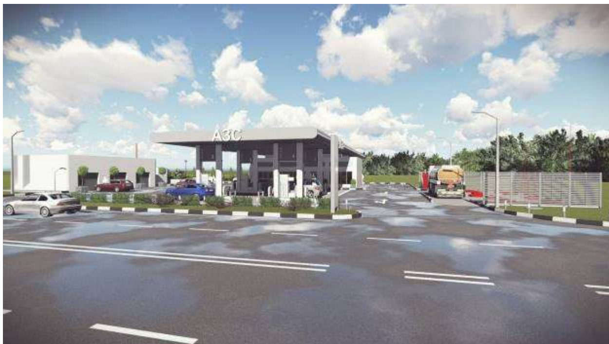
Подсветка островка и зоны въезда\выезда на АЗС
