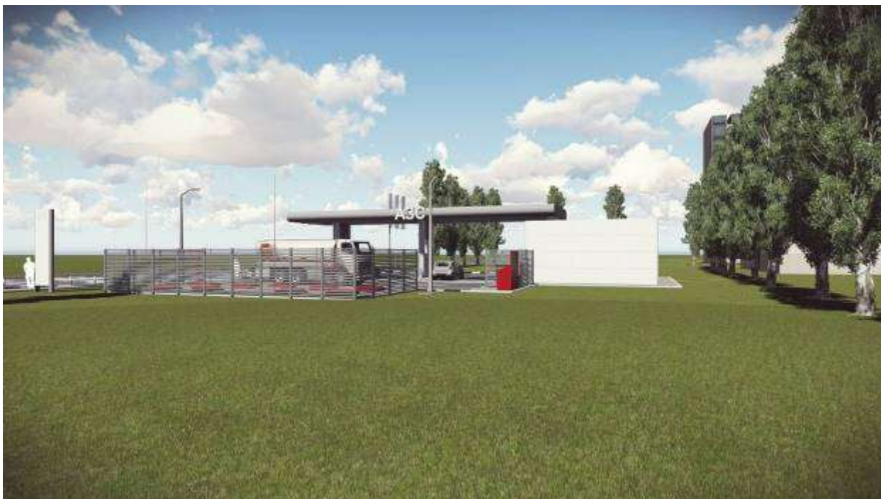
Ограждение мусорных контейнеров и контейнеров хранения топлива
